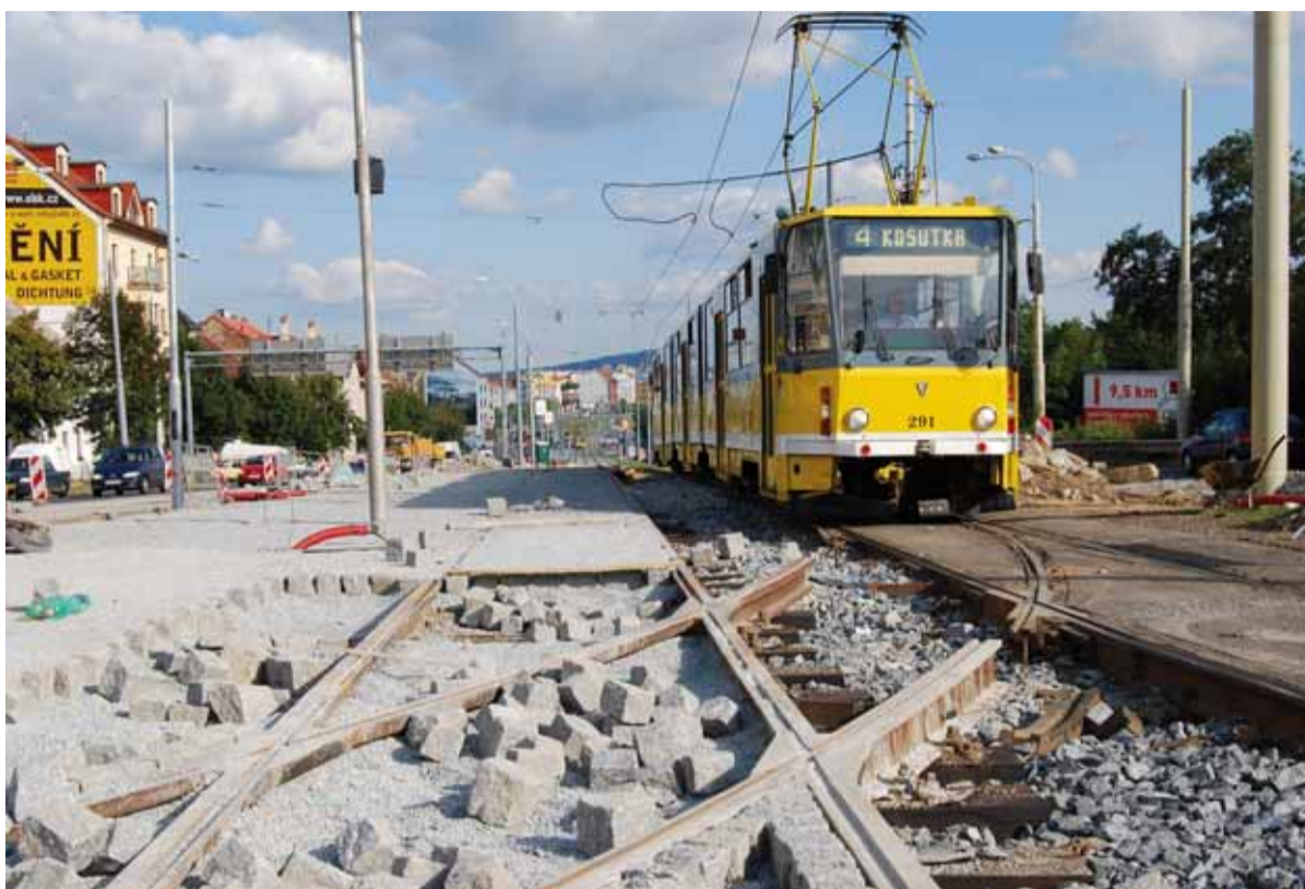
28. 7. 2009 projíždí starcešním tramvaj KT8D5 ve směru Košutka ještě po původní koleji. Vedle jsou už položeny koleje nové, včetně odbočení bovevecké větve. Foto Miroslav Klas
