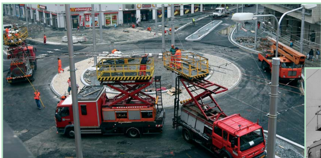
„Moderní montážní vozy měly své předchůdce nejen v šedesátých letech, ale už v roce 1933. Původně sloužila k údržbě trolejového vedení jen dvoukolá kára se šestimetrovým žebříkem.“
