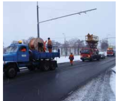
Natahování trolejbusových drátů v Borské ulici probíhalo i za nevládného počasí 17. prosince 2009.
