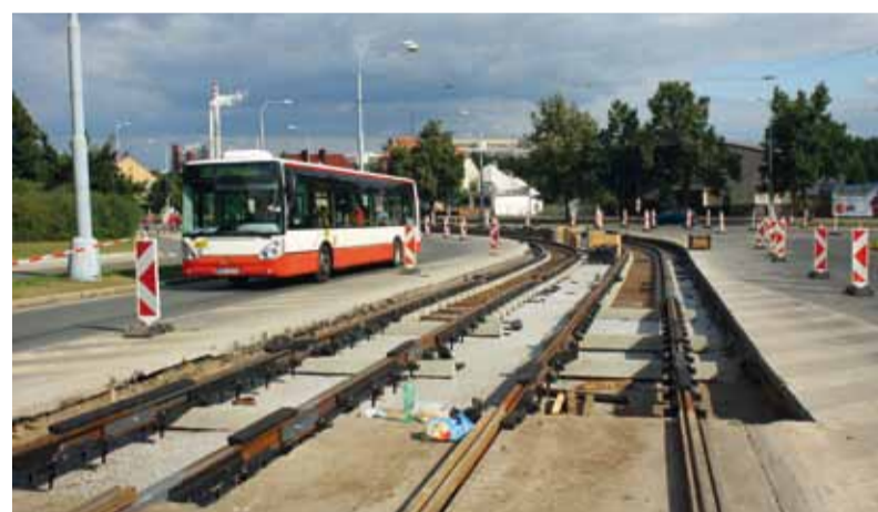
Rekonstrukce tramvajového oblouku v ulici Vejprnické a Terezie Brzkové. Foto Jan Šlehofer, 11. 8. 2012
