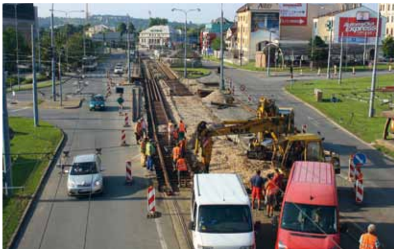
Opravy kolejí v křižovatce Sirkovce a Americké ulice. Foto Jan Šlehofer, 4. 7. 2012
