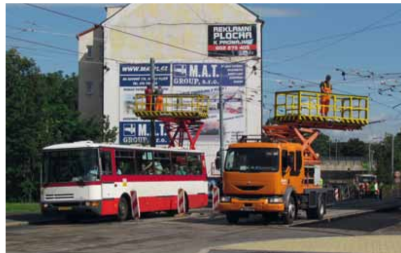
Na montáži trolejí spolupracovaly PMDP s firmou Elektroline. Místo tramvají jezdily autobusy, odkloněny byly i trolejbusy. Foto Zdeněk Kresa, 10. 7. 2012
