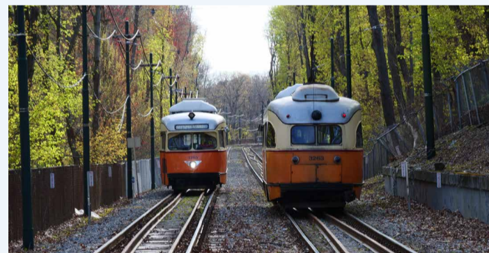
Velká část této rychlodrážní trati je z bezpečnostních důvodů oplocená.
