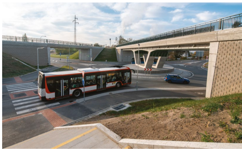
Dokončení kruhového objezdu ocenili zejména cestující z Bílé hory. Foto: archiv PMDP
