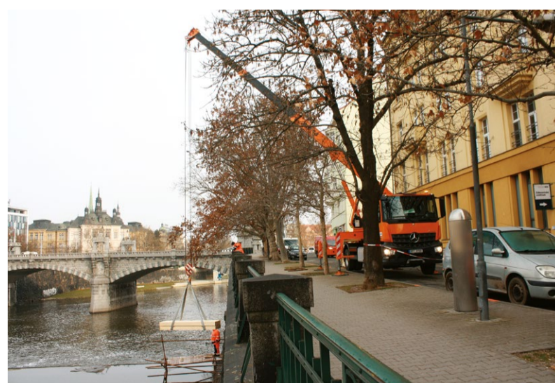
Transport trámů do malé vodní elektrárny. Foto: archiv PMDP
