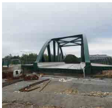
Uzávaný tramvajový most přes silnici č. 1/27, zatím bez kolejí.
