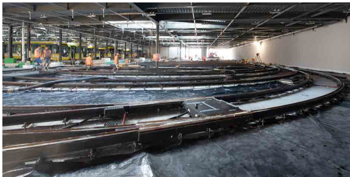
Výstavba probíhá za plného provozu.
